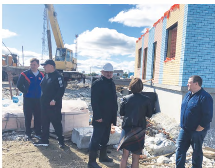
Уже видны контуры будущей школы – возводится 1-й этаж.
