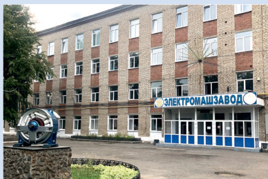
КЭМЗ. Главный корпус.
