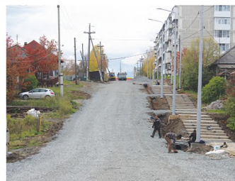
Работы на улицах Первомайской и Лесопильной.
