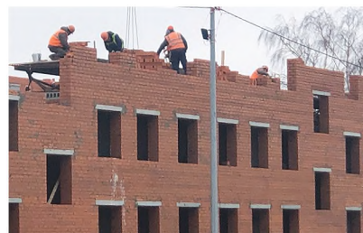
Продолжается строительство нового дома на перекрёстке улиц Луначарского – Лесопильная.
