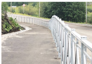
На мосту в заречной части установили ограждение.
