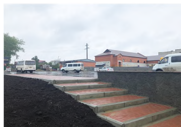
Завершаются работы по строительству площадки карпинского автовокзала.
